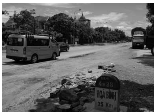
写真1 ベトナムでの路面性状調査
