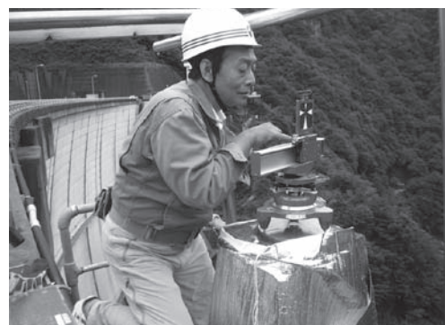
写真2 川治ダムの変動量調査測量
