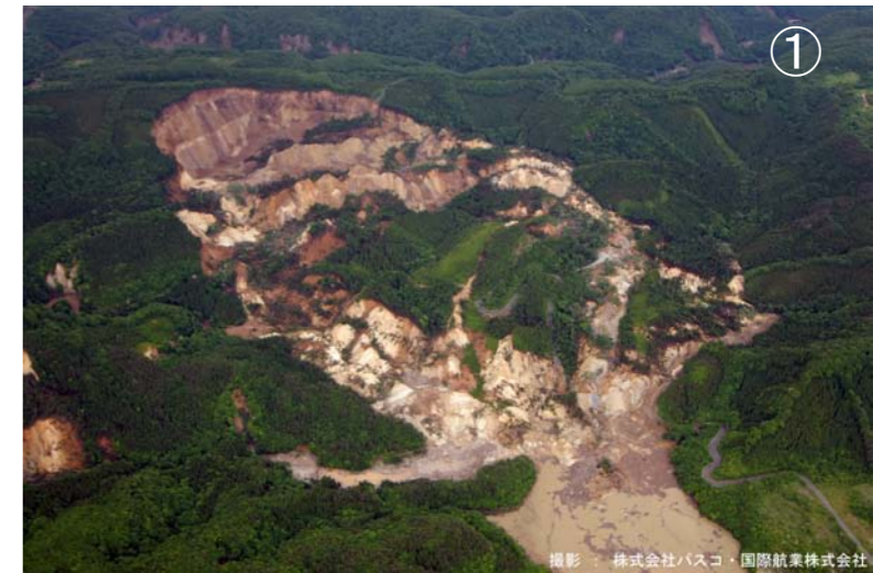
荒砥沢ダム貯水池上流で発生した大規模地すべり ・最大長 1500m ・最大幅 750m
