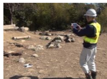
<対空標識の設置確認>
